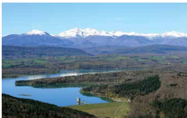
▲ Barrage de Montbel sur l'Ariège
